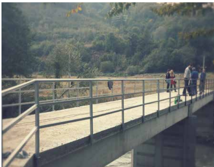
Die erneuerte Brücke
